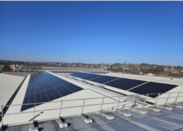
Namur Expo - installation de panneaux photovoltaïques
